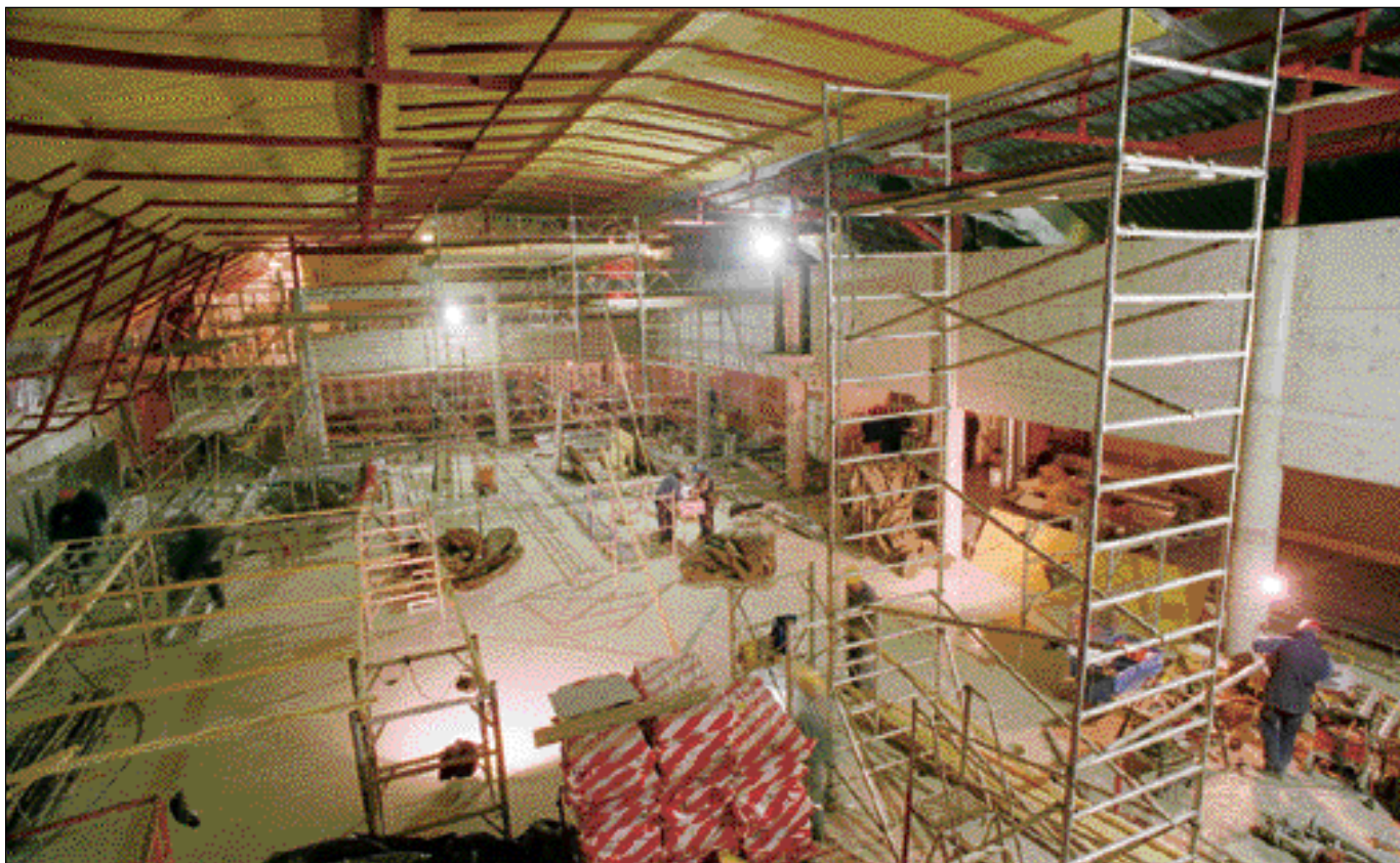
Rådningcentralen ligger närmare 30 meter rakt under Johannes Brandstation i centrala Stockholm. Skanska var generalentreprenör för sprängning och undermarksbyggnader. 30 000 m 3 berg sprängdes bort för att få plats med byggnaden.
